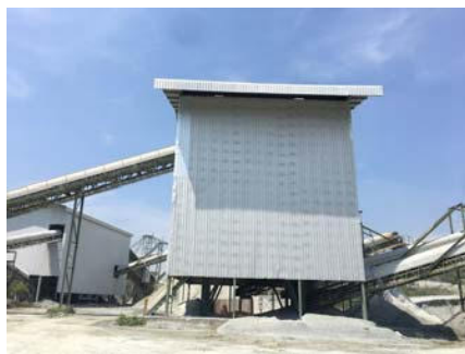
รูปที่ 2-24: โรงโม่หินระบบปิด
