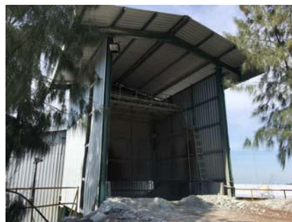
รูปที่ 2-27: การปิดคลุมถังรับหินใหญ่
